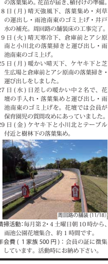
周回路の舗装(11/18)
